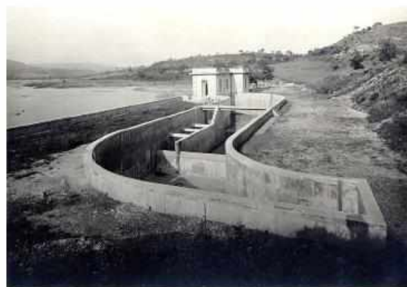
Opera di Presa sul fiume Sele
