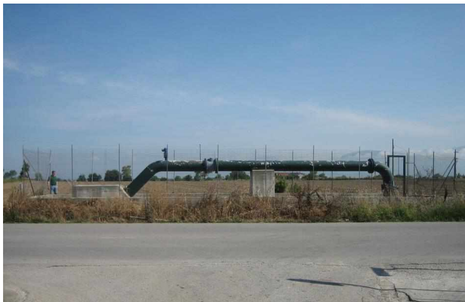
Cavallotto esistente di consegna ai reparti irrigui
