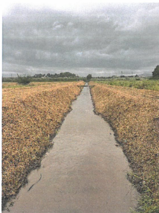
Canale in terra
