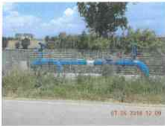
Cavallotto di consegna ai reparti irrigui (estesi 150 – 200 ettari)
