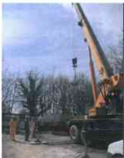
Autogrù posizionata al pozzo 2.
