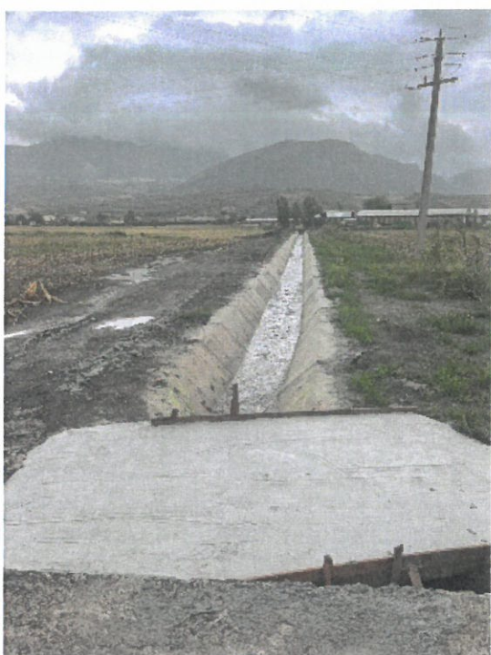
Canale con rivestimento in calcestruzzo
