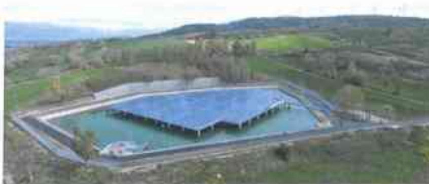
Vasca di Scigliati (basso servizio) alimentata dall'impianto di sollevamento di Scigliati.
