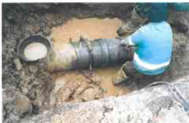
Interventi sulla rete per eliminare le perdite.
