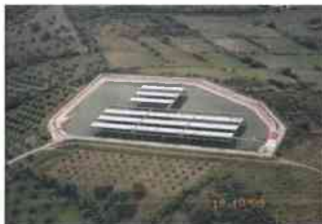
Vasca di Tempa San Paolo (alto servizio) alimentata dall'impianto di sollevamento di Scigliati
