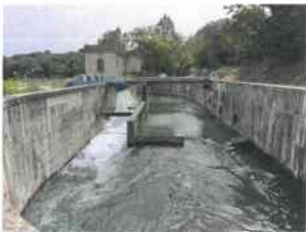
Opera di Presa sul fiume Sele in loc. Pagliarone
