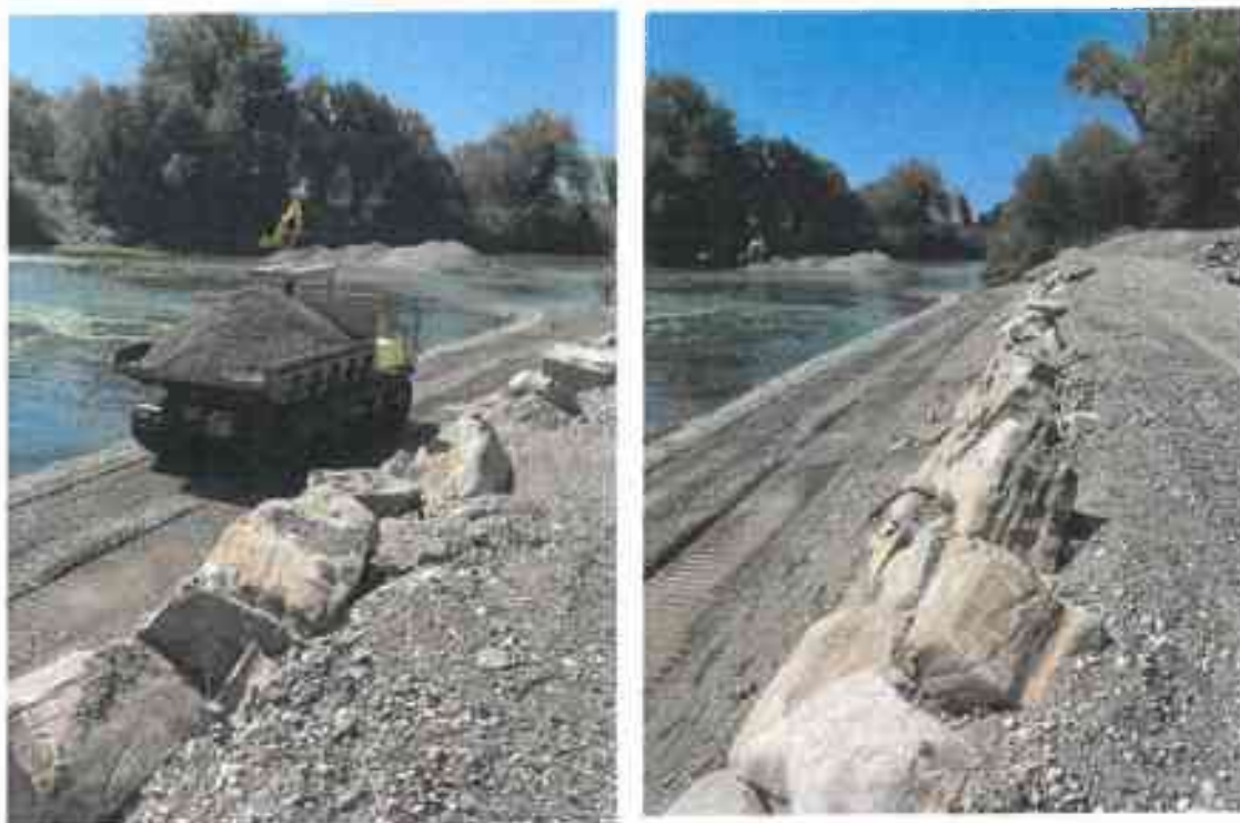
Ricostruzione sponda Dx del Fiume Sele
