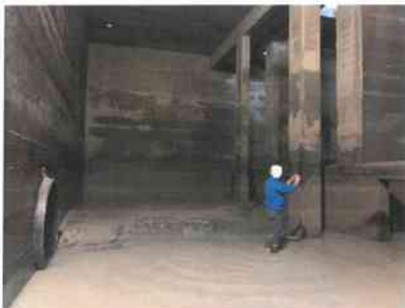
Rimozione del fango depositato sul fondo della Vasca di arrivo della galleria idraulica di Ponte Barizzo.
