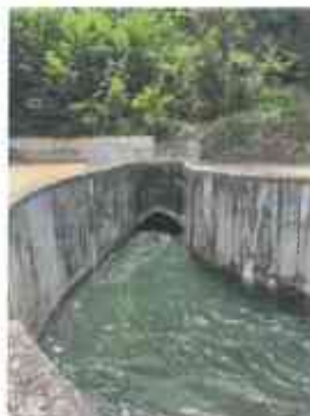
Imbocco galleria idraulica in loc. Pagliarone
