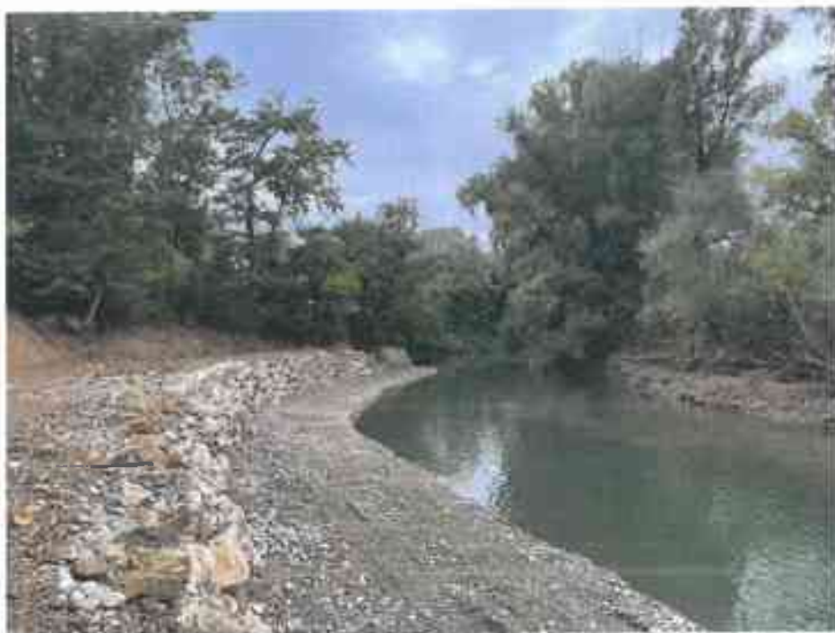
Ricostruzione sponda Sx del Fiume Calore Salernitano
